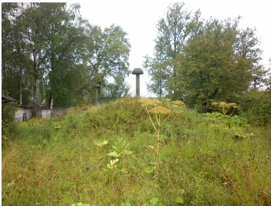
Рисунок 21. Резервуары чистой воды ВНС №1 (мкр. Черная Речка)
