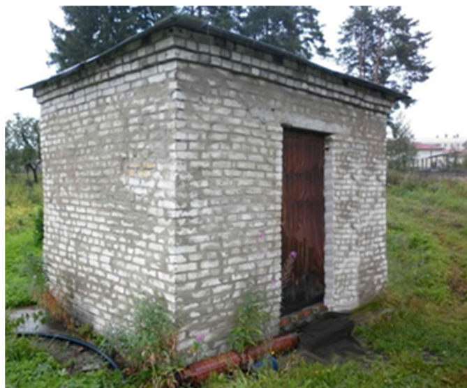
Рисунок 7. Внешний вид и оборудование скважины №8
