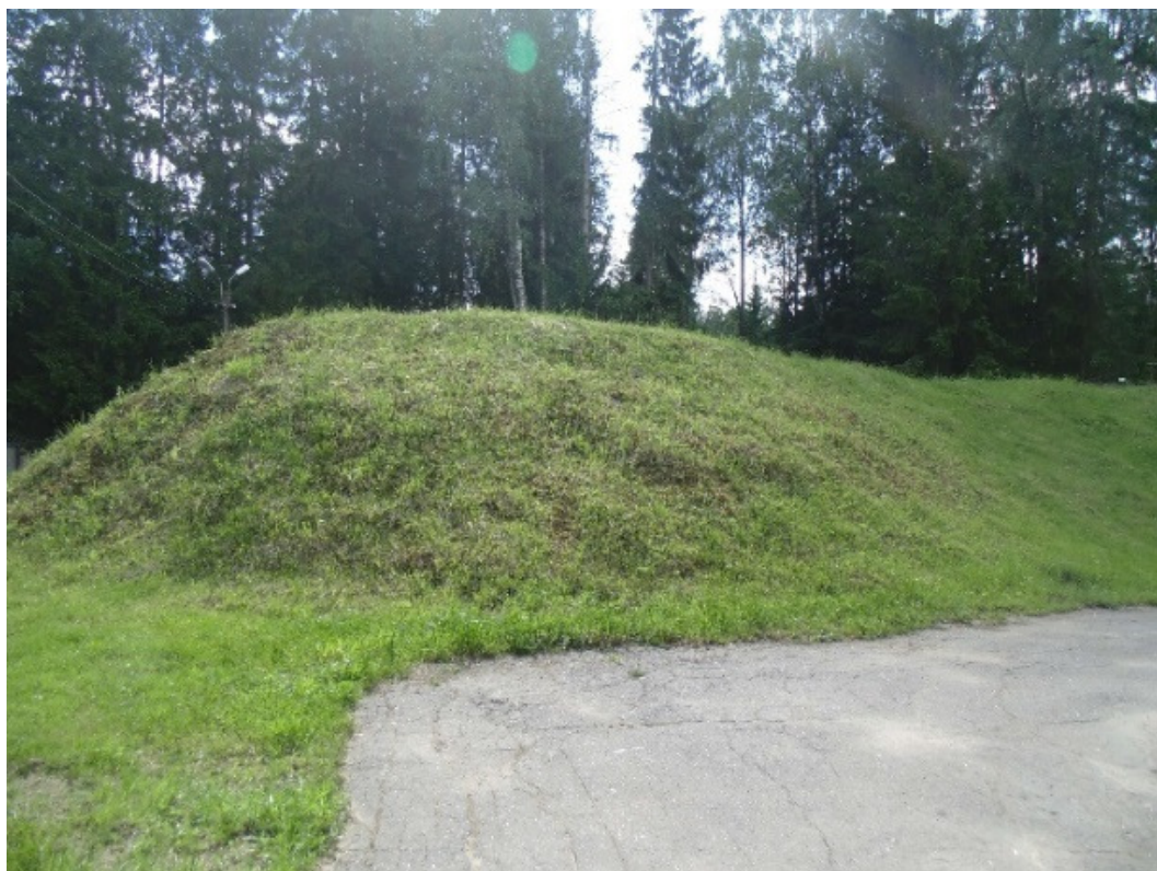
Рисунок 19. Резервуары чистой воды ВНС №8 (мкр. Сертолово-2)
