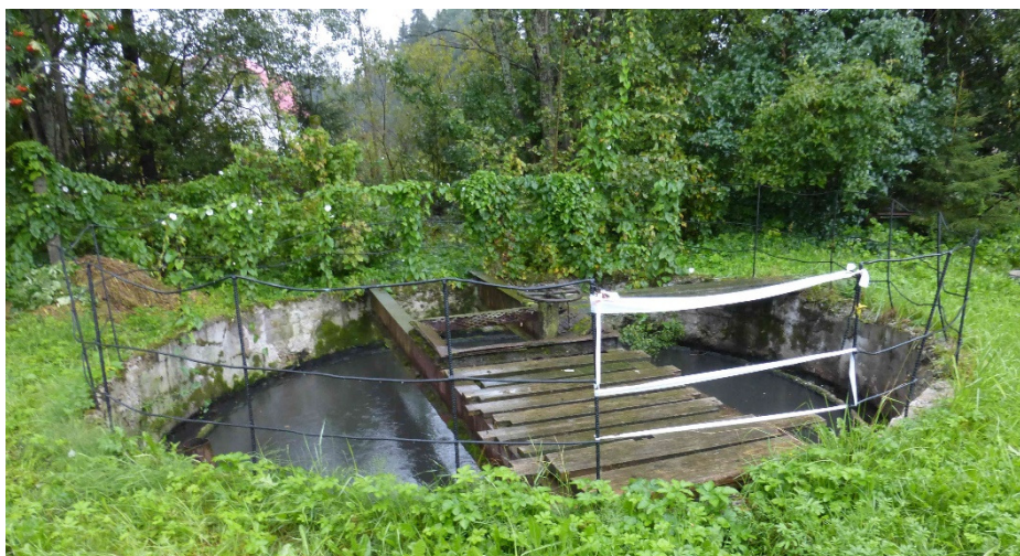
Рисунок 40. Контактный резервуар КОС мкр. Черная Речка
