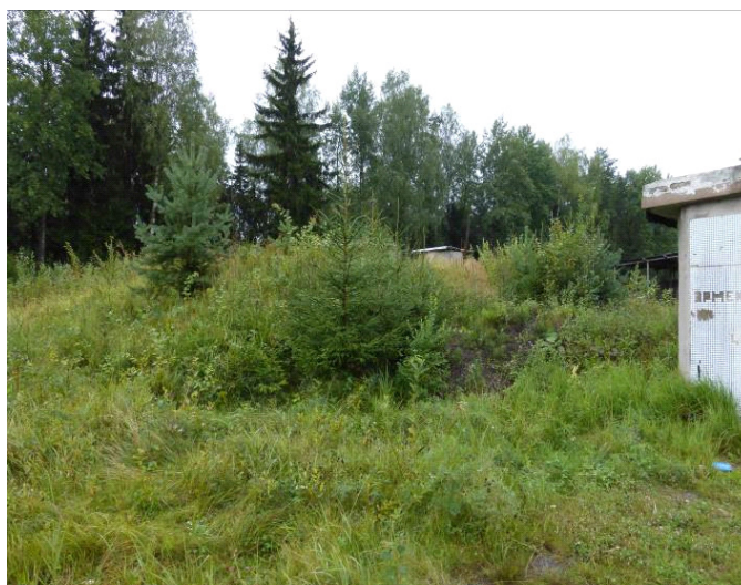
Рисунок 12. Резервуары чистой воды мкр. Сертолово-1, в/г Сертолово-3
