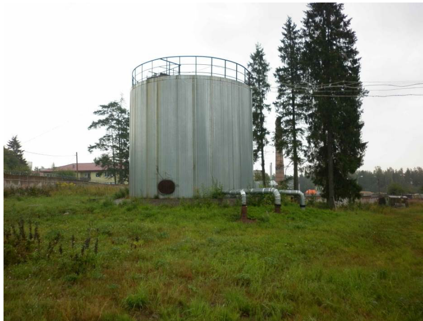
Рисунок 23. Резервуары чистой воды ВНС №2 (мкр. Черная Речка)
