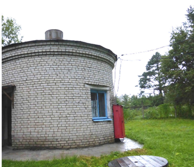
Рисунок 48. Внешний вид и оборудование КНС мкр. Черная Речка
