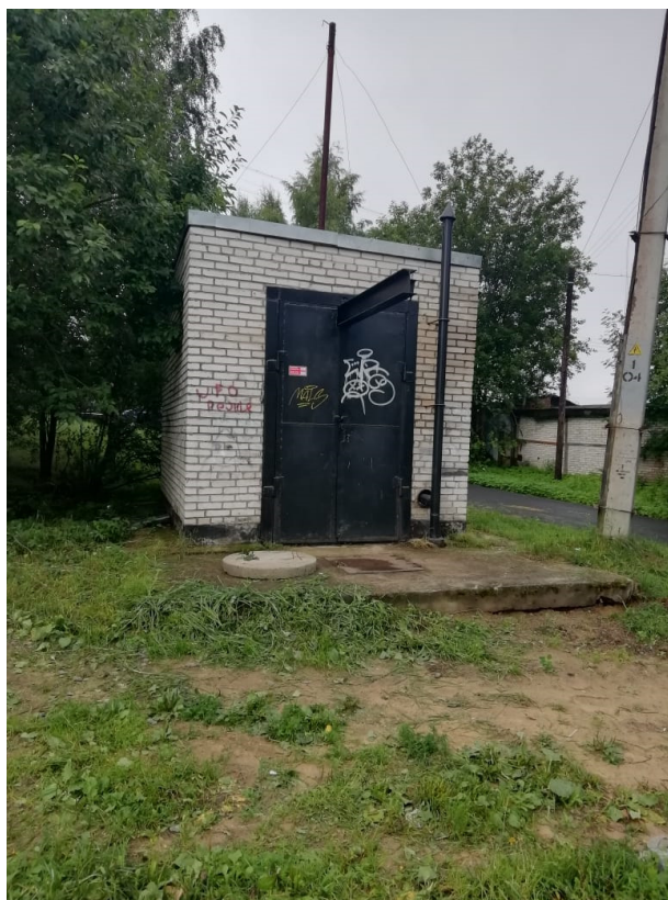
Рисунок 46. Общий вид здания КНС «Заречная»
