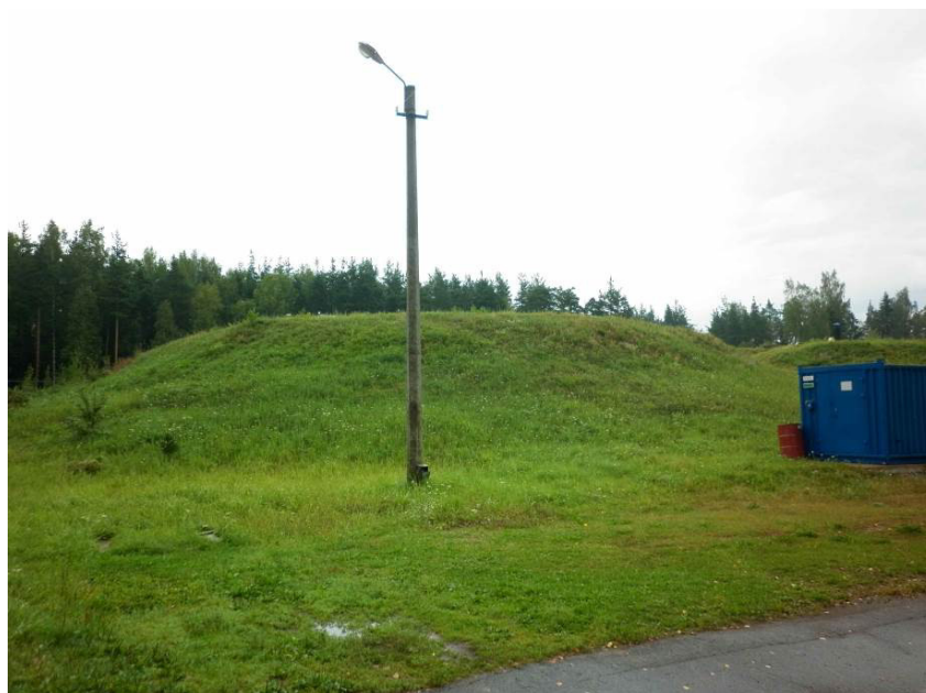
Рисунок 15. Резервуары чистой воды ВНС №1 «Главная»
