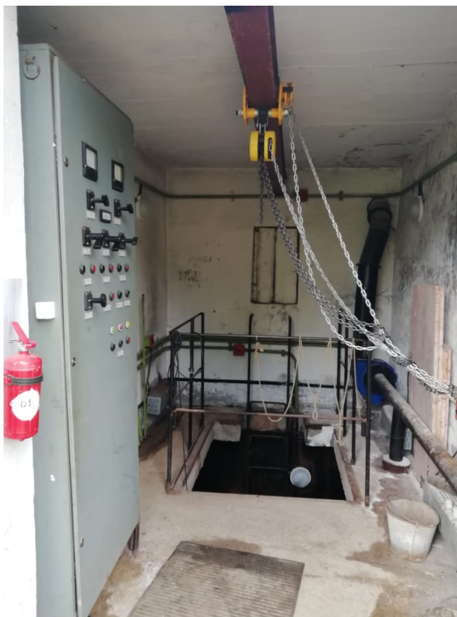
Рисунок 47. Оборудование КНС «Заречная»
